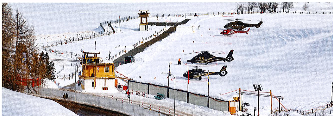
Der neue Heliport-Lago wurde direkt am Ufer des Davosersees aufgebaut und war rund dreimal grösser als der bisherige Stilli-Heliport.
